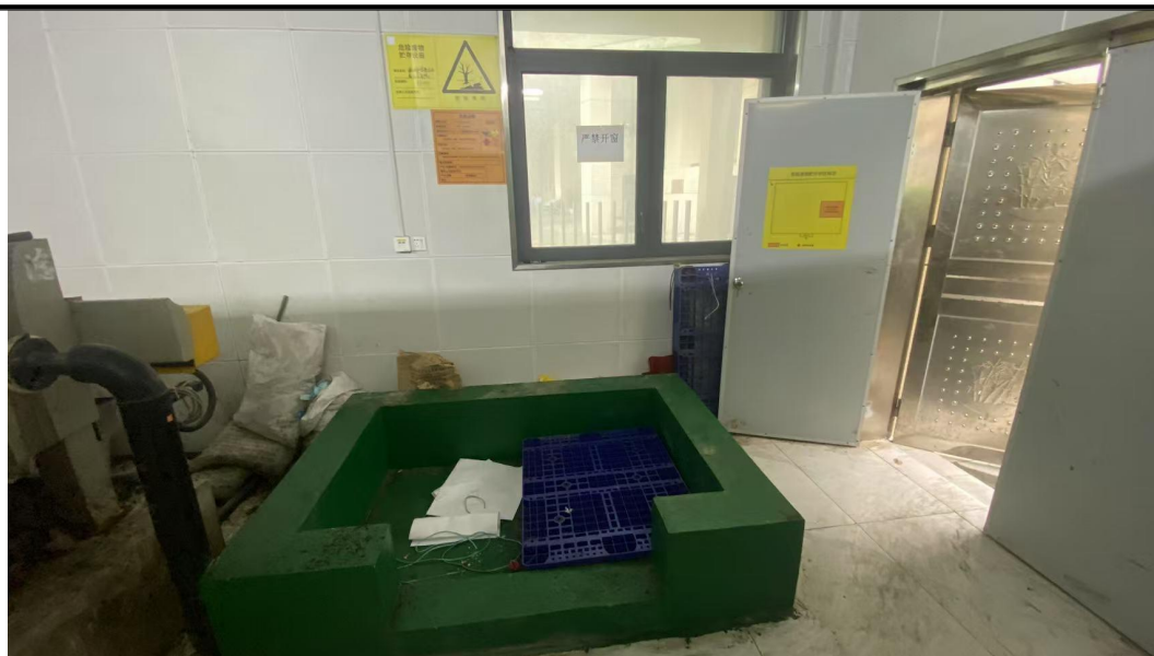
图2-5 项目污水处理站污泥存放区现场照片
